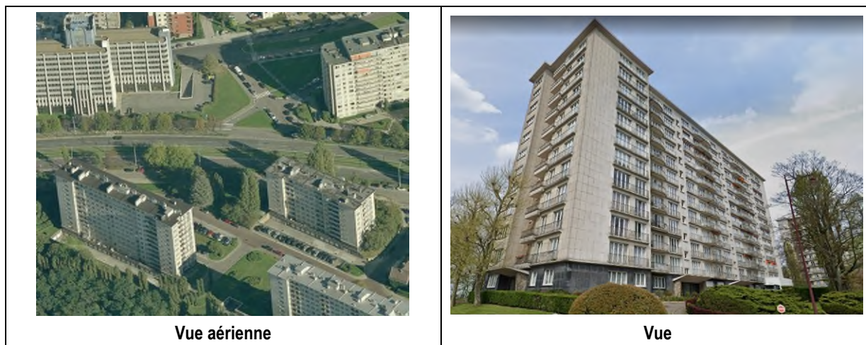
Figure 46 : Barres d'appartements et de bureaux à l'est (Bingmaps et ARIES, 2021)
