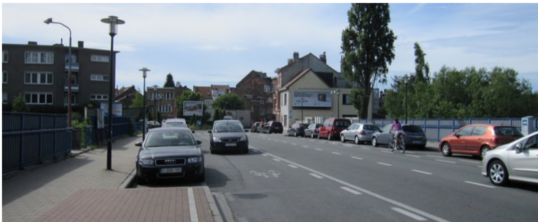
Figure 52 : Vue du pont rue Auguste de Boeck (ARIES, 2021)
