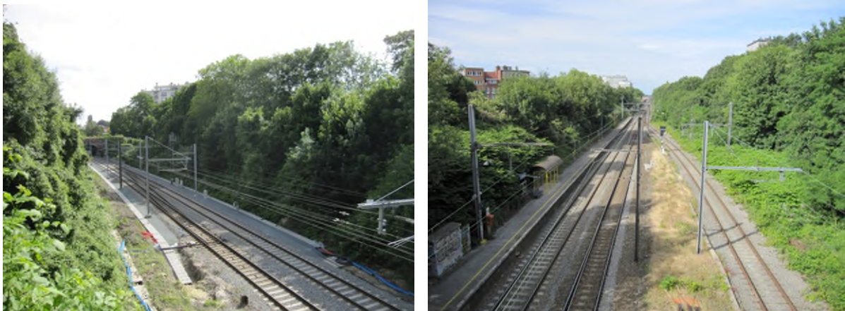
Figure 51 : Vue des voies ferrées au sud du site (à gauche) et au nord du site (à droite) (ARIES, 2021)
