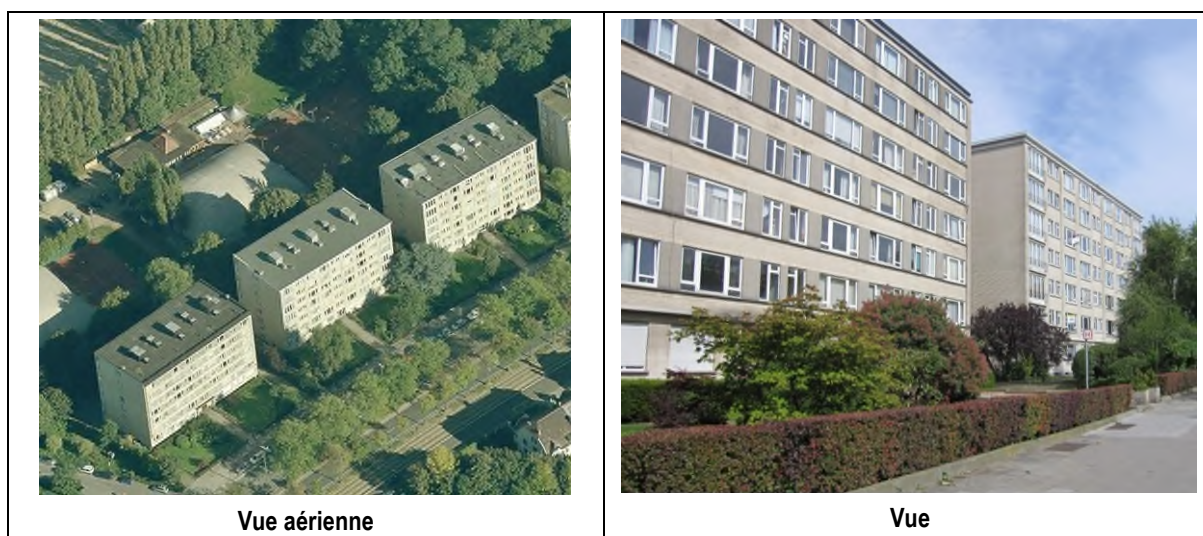
Figure 45 : Immeubles d'appartements au sud (Bingmaps et ARIES, 2021)
