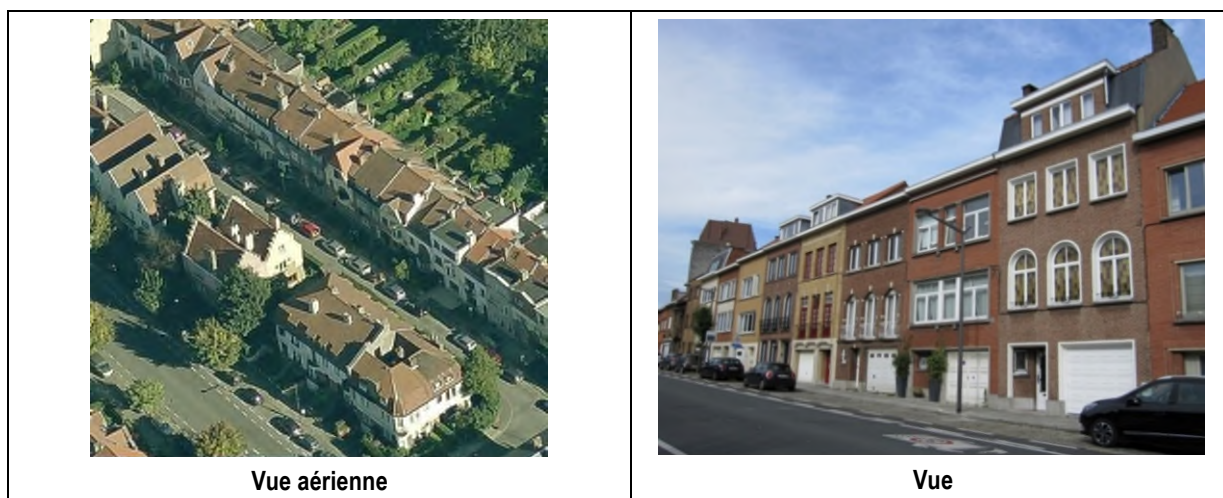
Figure 40 : Constructions mitoyennes à l'ouest et au nord-ouest (Bingmaps et ARIES, 2021)
