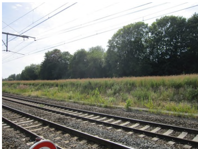
Figure 61 : Vue des talus verdurisés (ARIES, 2021)
